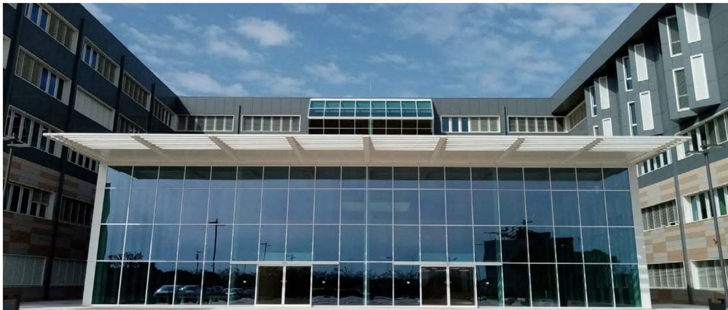
Opere di ampliamento serramenti in alluminio a taglio termico e facciate continue con ingressi Ponzi / Ponzi: curtain walls, windows and doors complete supply for public hospital
