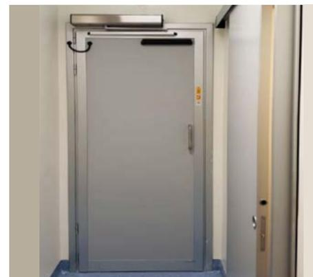
Anta automatica a battente con anta pannellata
